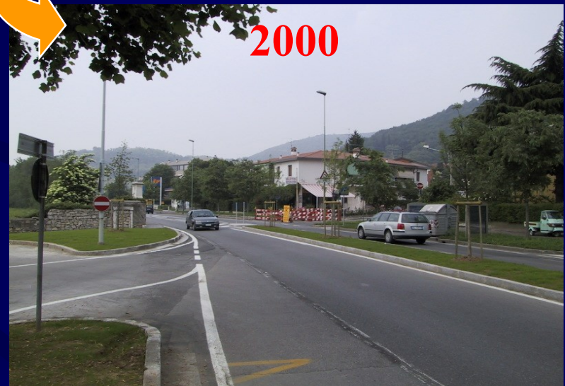
Restringimento corsie con aiuola spartitraffico e piantumazione
