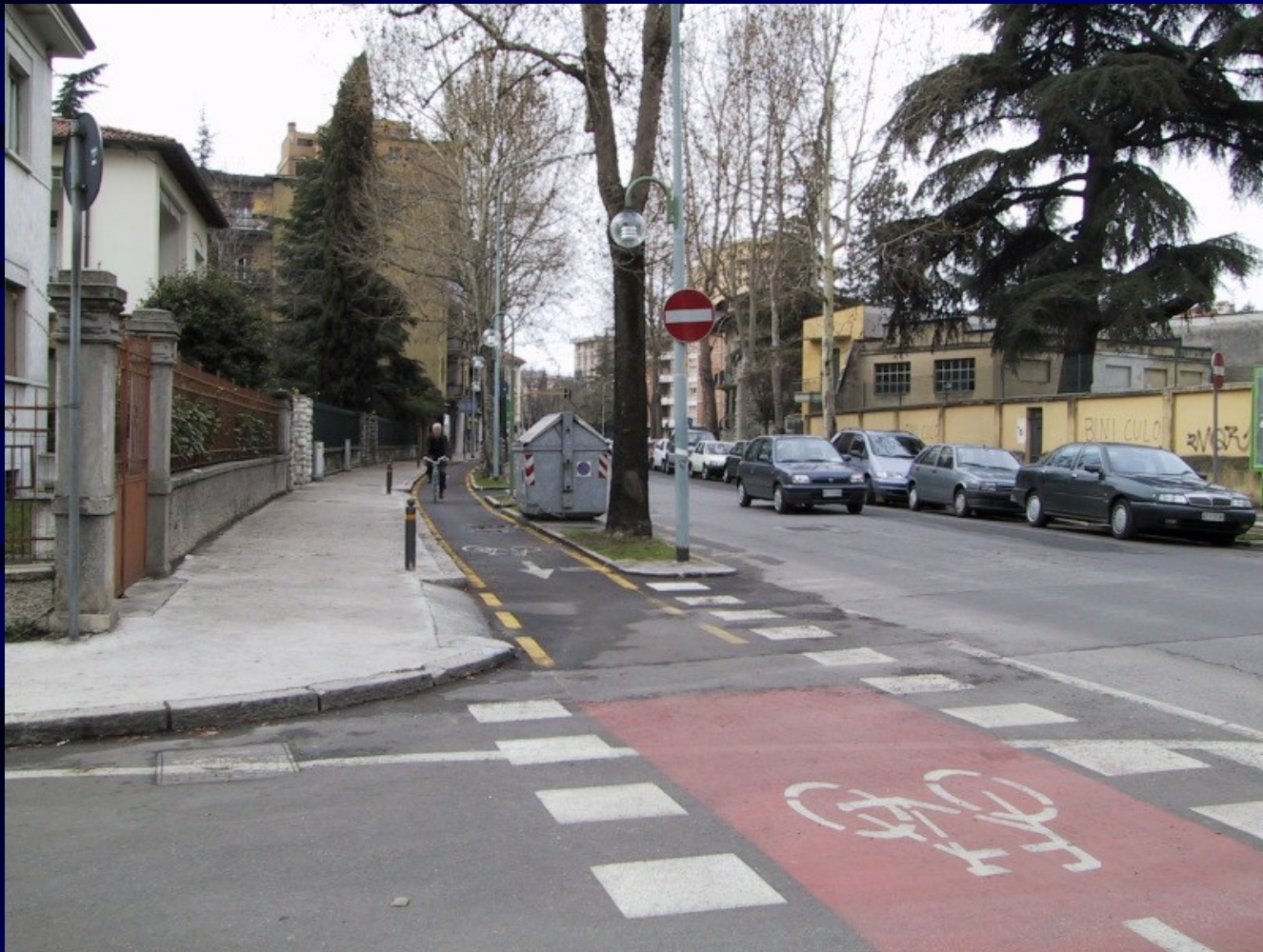
Applicazione di fondo rosso sulla pista ciclabile in corrispondenza dell'attraversamento
