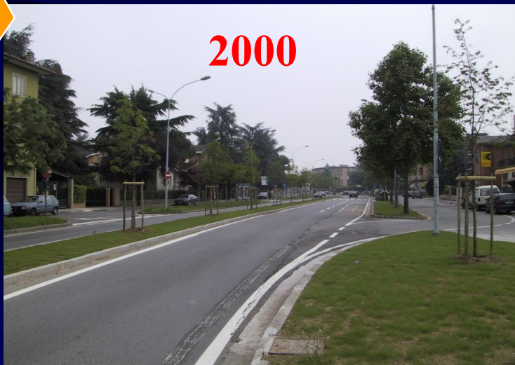
Restringimento corsie con aiuola spartitraffico e piantumazione
