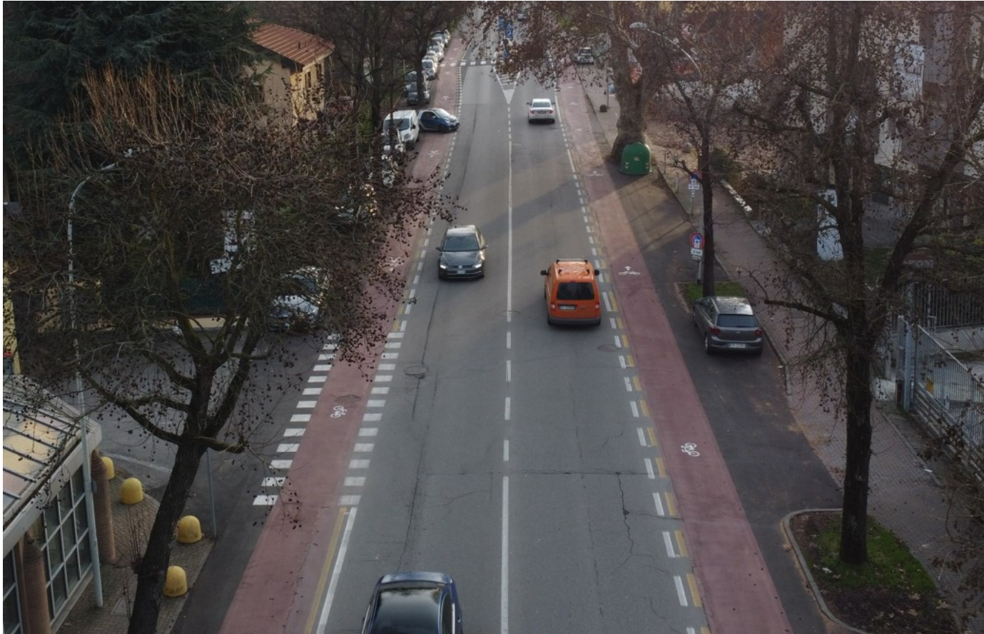
LODI (LO) – Viale Milano Progetto Chiarini 2021 – Realizzazione 2022
