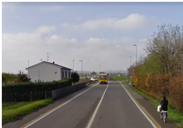
SP359R Emilia Romagna Banchine trasformate in corsie ciclabili (Foto da WEB 2010)
