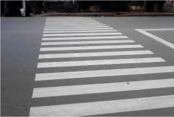
1_Attraversamento pedonale ("strisce zebra")
