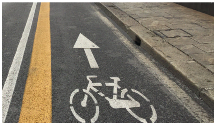
Pista ciclabile su corsia riservata in carreggiata
