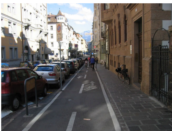
Pista ciclabile su corsia riservata su marciapiede
