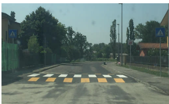
Esempio di attraversamento rialzato
